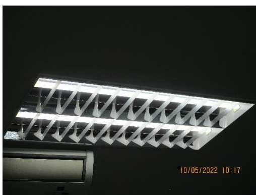
รูปที่ 2-26 การติดตั้งแผ่นสะท้อนแสง
