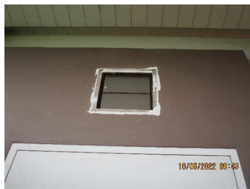
รูปที่ 2-19 ช่องระบายอากาศห้องเก็บสารเคมี
