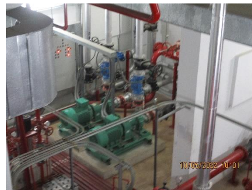
รูปที่ 2-53 Fire Pump System
