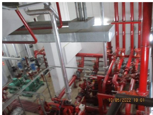
รูปที่ 2-53 Fire Pump System
