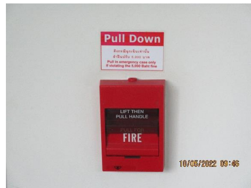
รูปที่ 2-50 Emergency Fire Button
